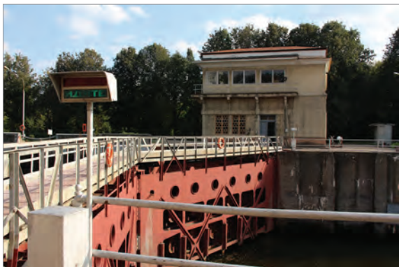
Рис. 6. Шлюз №10, Перервинский гидроузел, г. Москва. Рисунок автора
