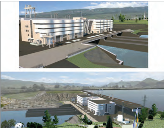
Рис. 4. Красногорские малые ГЭС-1 и ГЭС-2. Карачаево-Черкесская Республика. Авторский коллектив АО «Мособлгидропроект», ПАО «Русгидро»
