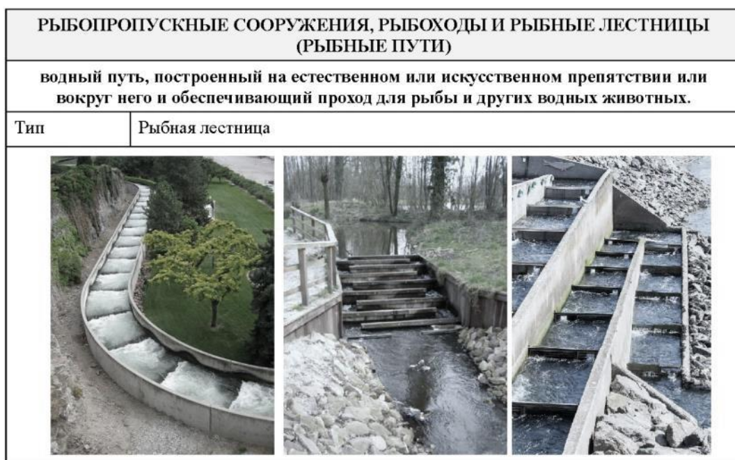
Рис. 3. Рыбные лестницы как элемент функционального дизайна архитектурного ансамбля гидроузла (Рисунок автора)
